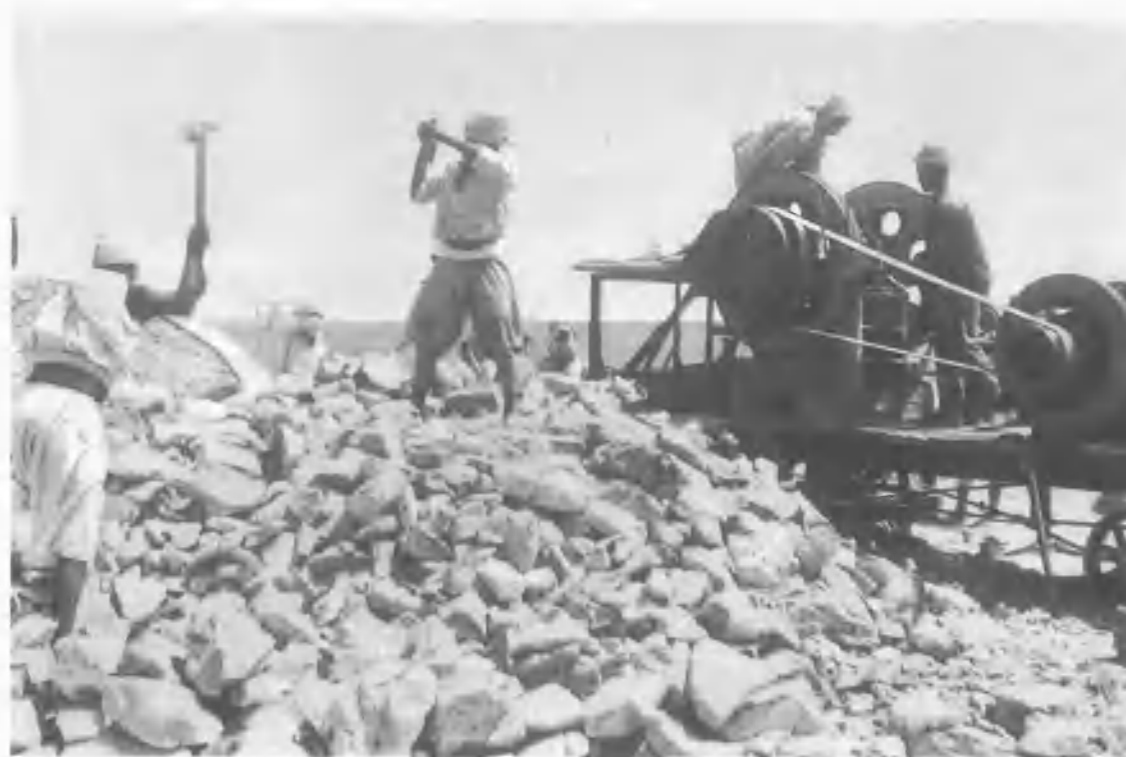
MACCHINE E MEZZI D'OPERA: Spaccapietre e frantoi.
