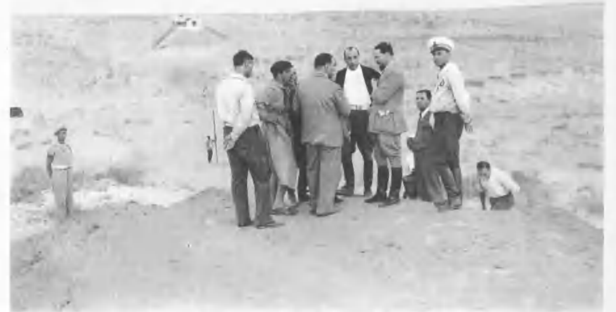
I TECNICI RIFERISCONO SULLA COSTRUZIONE DEL PONTE ATTRAVERSO L'UADI AMRA (TRA SIRTE ED EN NUFILIA)
