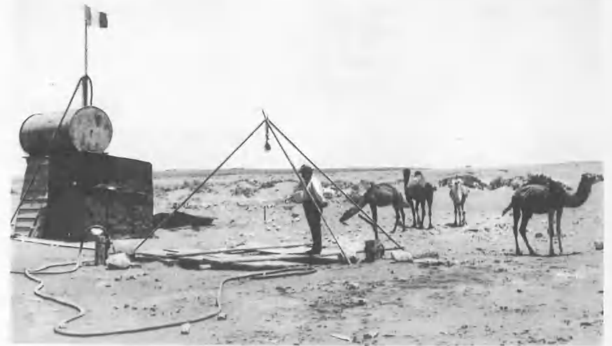
CASTELLO DI NEUMA: Depositi interrati di emulsione bituminosa.
