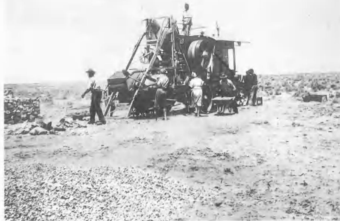
UNO DEI GIGANTESCHI FRANTOI MECCANICI AL LAVORO SUL QUINTO TRONCO TRA BUERAT E SIRTE
