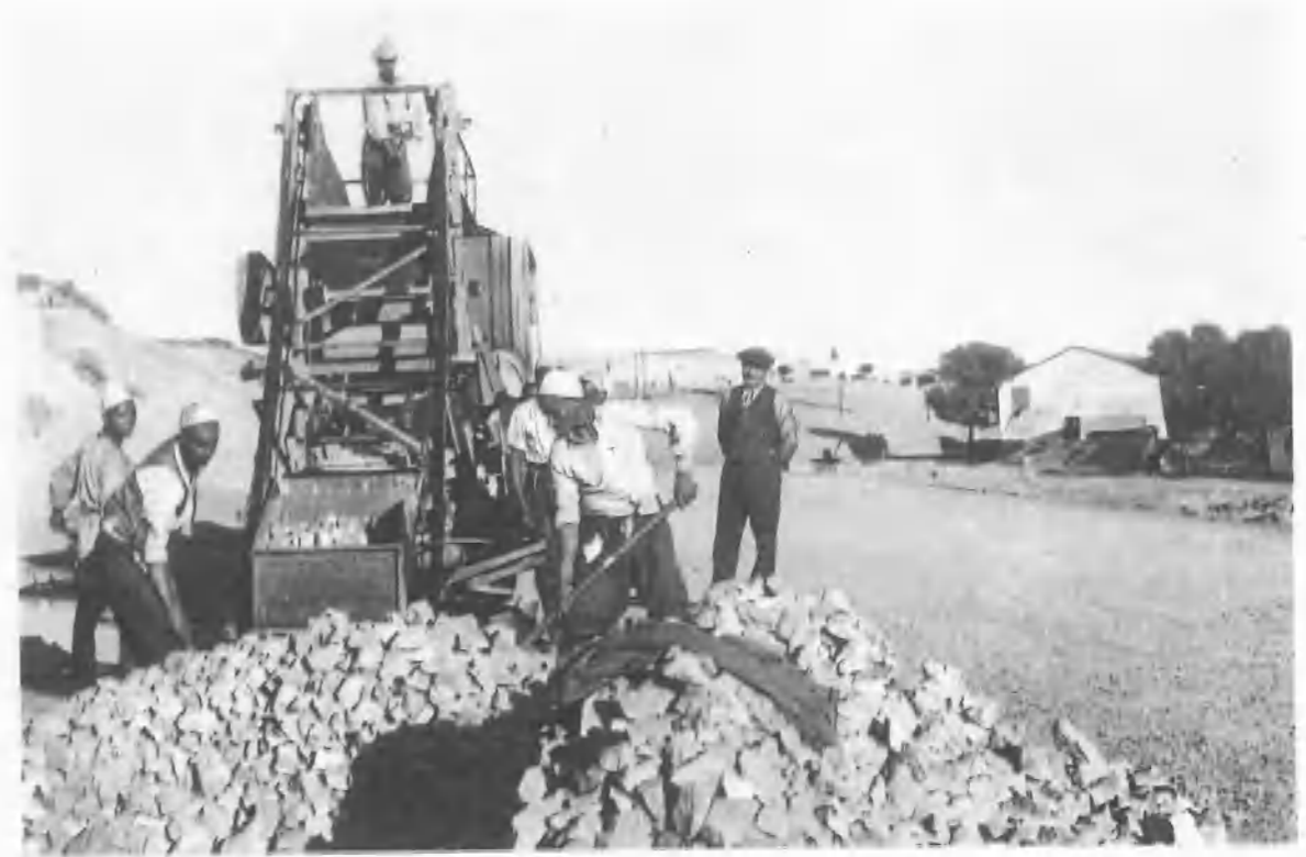
SUL QUINTO TRONCO, TRA BUERAT E SIRTE AL KM. 87: Operai indigeni attendono ai frantoi per la preparazione del pietrisco.
