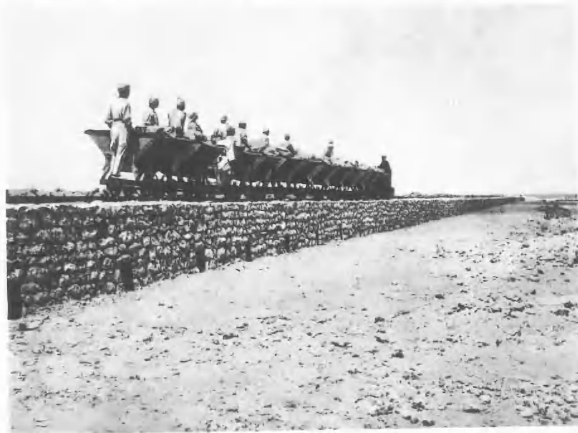
MACCHINE E MEZZI D'OPERA: Decauville per trasporto di materiali sul quinto tronco tra Buerat e Sirte.
